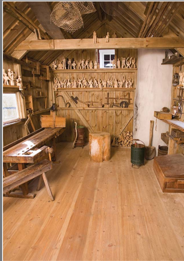
Astrid Lindgren shop (tv) og Emil Lönneberga hus (th). Udført af Föllinge Golv. Massiv Fyr Planker i dim. 30mm x 280 x fld. Igd.
